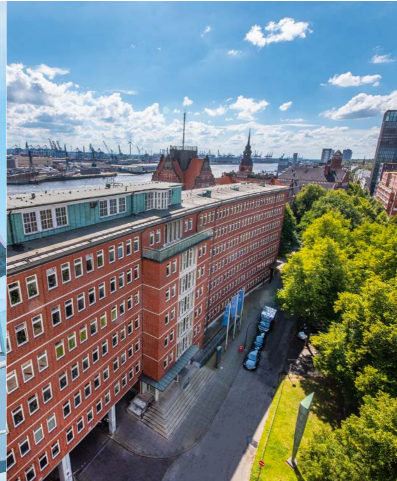
Zwei Gebäude des BSH in Hamburg (links) und Rostock (rechts)
