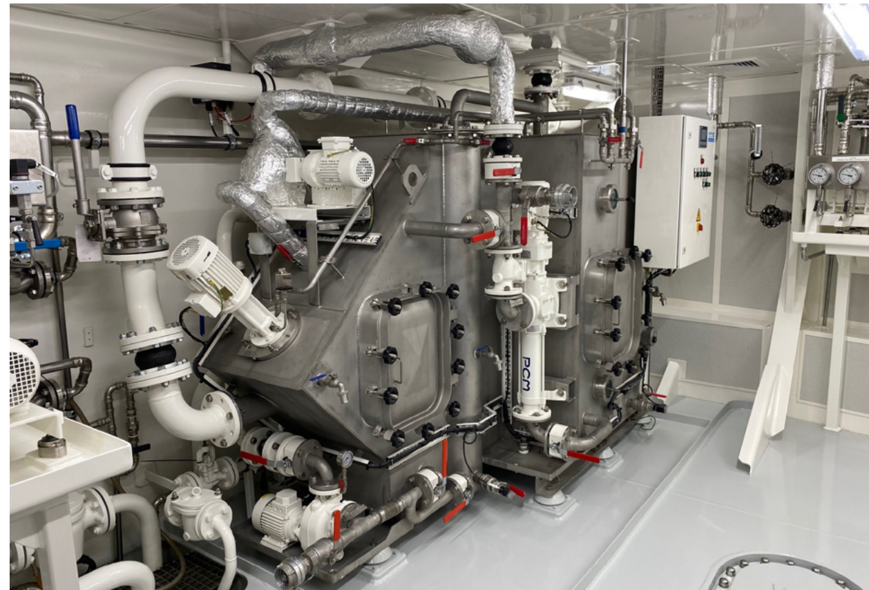
Saubere Bordlösung: Diese Anlage reinigt das Küchenabwasser von Ölen und Fetten
