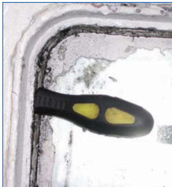
Undichte Fensterabdichtung
